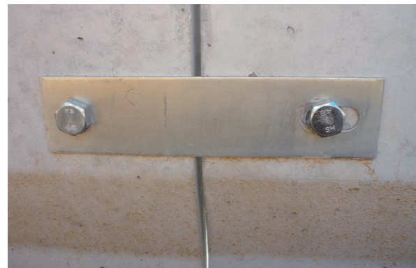
連結プレート取付状況
