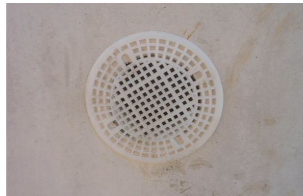
水抜孔用フィルター (背面側)
