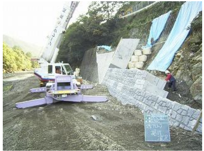
据付全体状況
