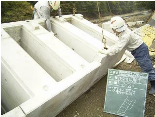
大型ブロック据付状況
