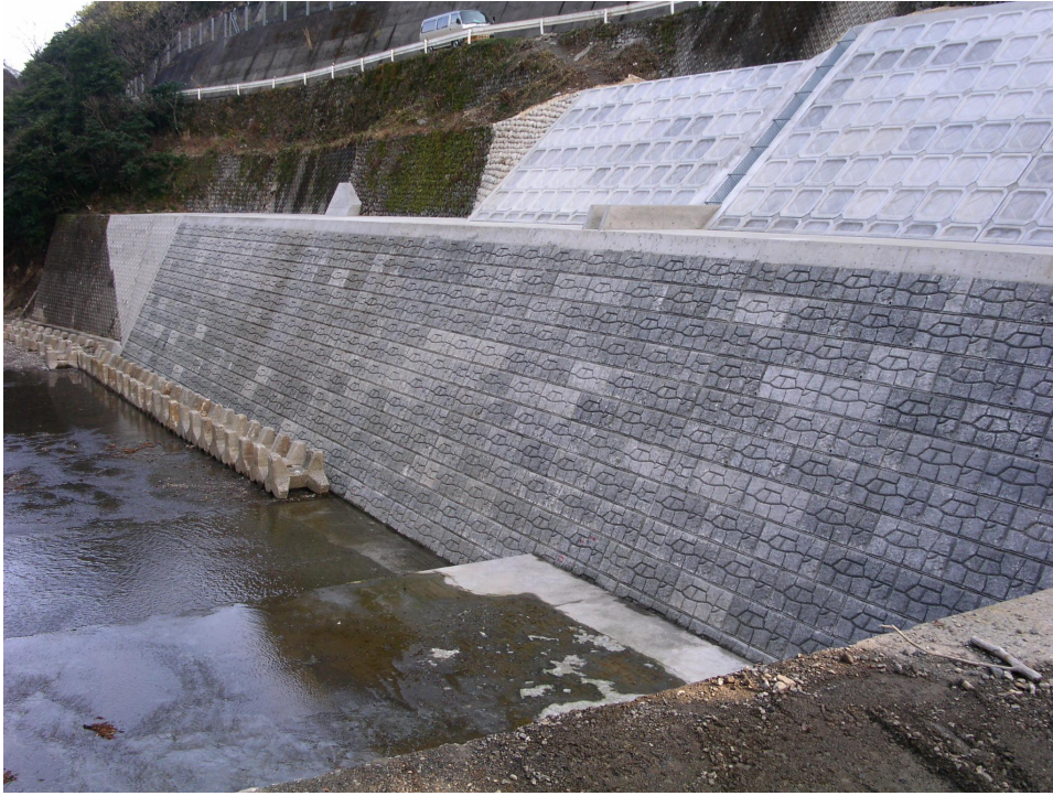
東和建设株式会社「一般国道 422 号道路災害復旧工事」(紀北県民局建設部) 使用ブロック : 175 型 (ポーラス)
