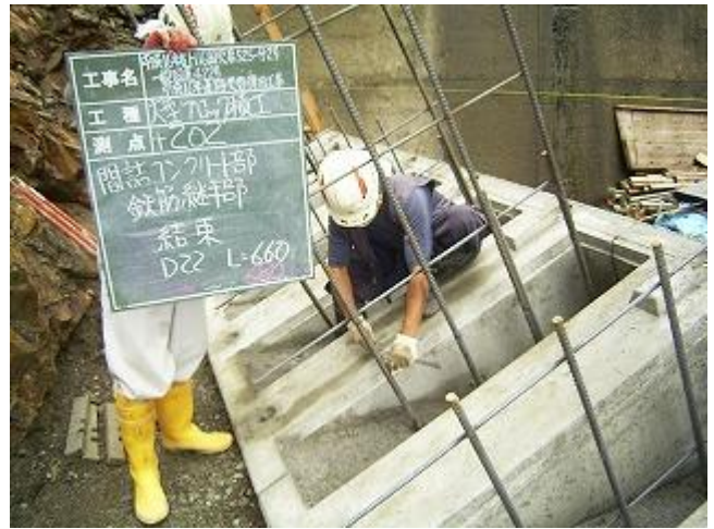
連結鉄筋結束状況
