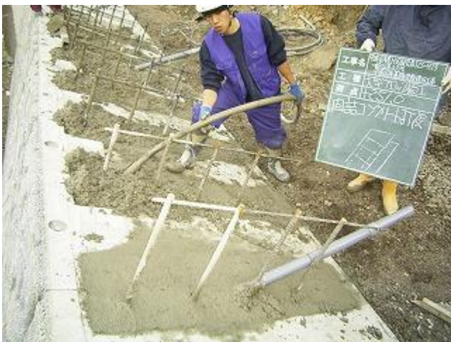
間詰コンクリート打設状況
