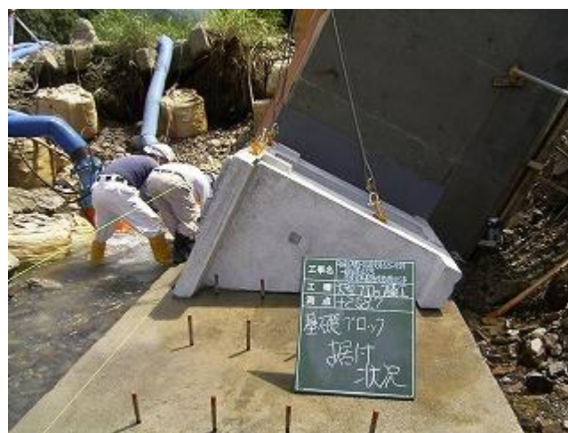
基礎ブロック据付状況
