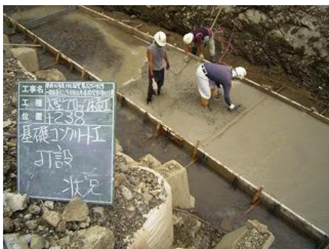
基礎コンクリート打設状況
