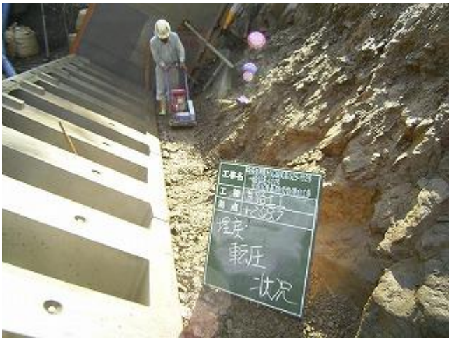
埋戻し転圧状況
