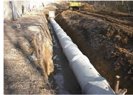
バイコン台付管施工事例
