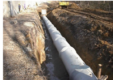
バイコン台付管施工事例
