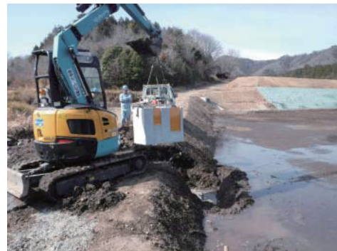
バックホウでの施工が可能
