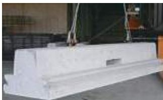
手順3- 吊り上げ、設置後、アイビーを取外し、
