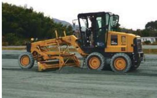
雑草などを伐採してから、モータグレーダで地盤を不陸修正し、振動ローラーにて転圧します。
