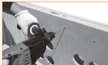
①ハンマードリルで $\phi 4.3\text{mm}$ ×深さ25mmの穴を対象面に対し直角に穿孔する。
