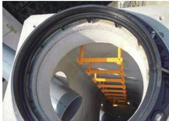
※鉄蓋、調整リング又は、頂版の高さ調整はモルタルで対応
