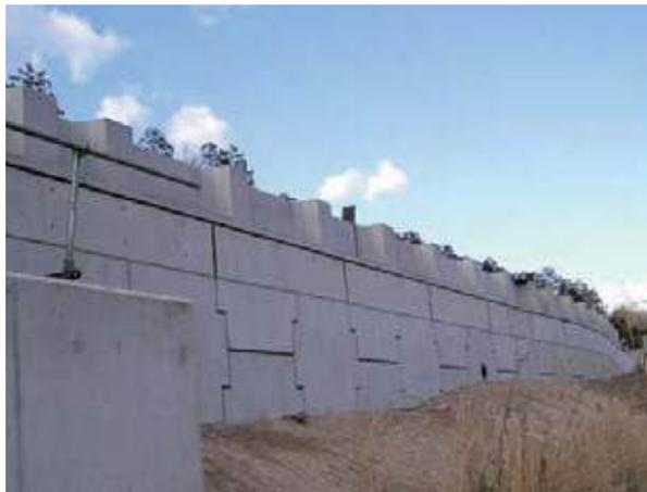
補強土壁直上設置の事例
