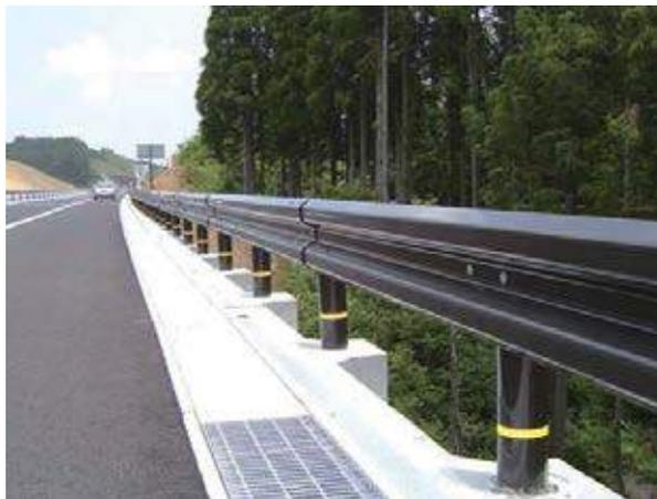
背面に側溝設置の事例
