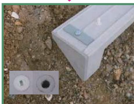
⑥インサートキャップを外しプレートをボルトで固定
