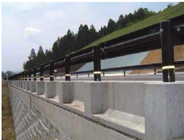
補強土壁直上設置の事例
