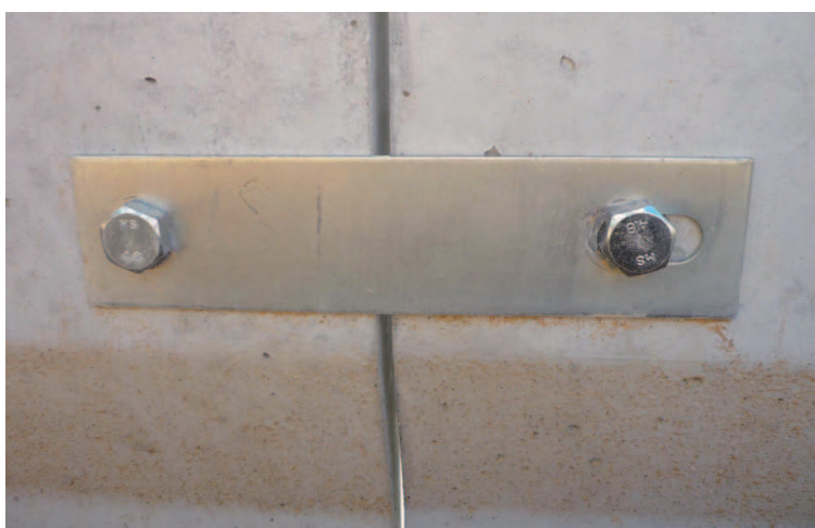
連結プレート取付状況
