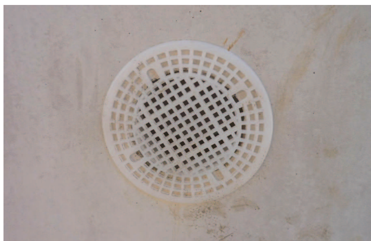
水抜孔用フィルター（背面側）
