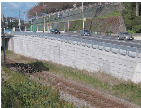
超軽量盛土直上設置の事例
