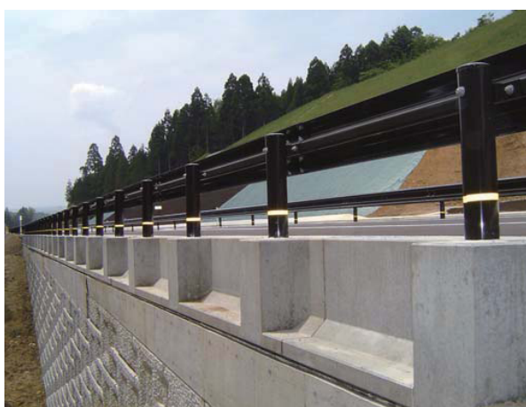
補強土壁直上設置の事例
