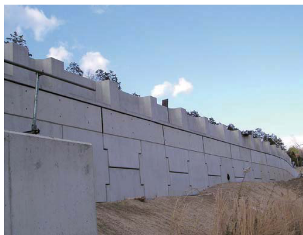
補強土壁直上設置の事例
