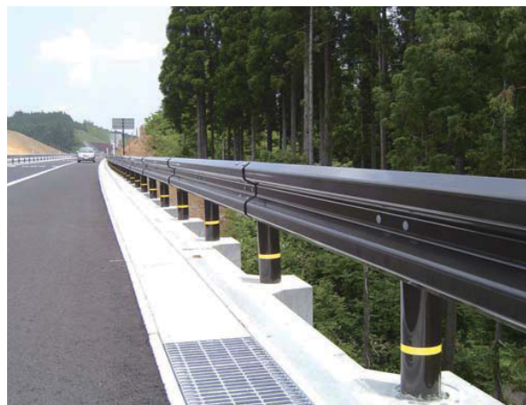
背面に側溝設置の事例
