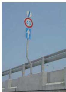
道路付帯構造物設置例(照明・標識・防風柵)
