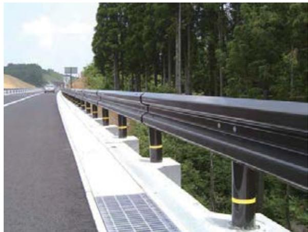
背面に側溝設置の事例
