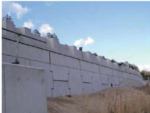
補強土壁直上設置の事例
