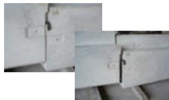
止水パットが剥がれないようにゆっくり落とし込みます。
