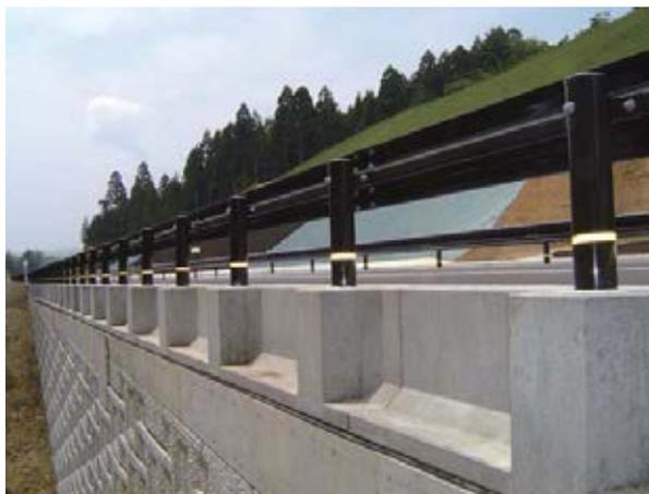
補強土壁直上設置の事例
