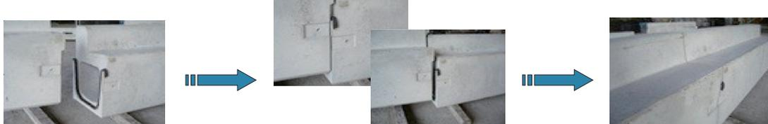
凸ジョイント側を凹ジョイント側に軽く当てるように合わせます。
