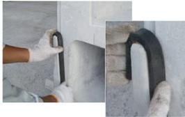
凹ジョイントをウエスなどで清掃し、止水パットが5～10cm程度はみ出すような状態から貼り始めて下さい。
