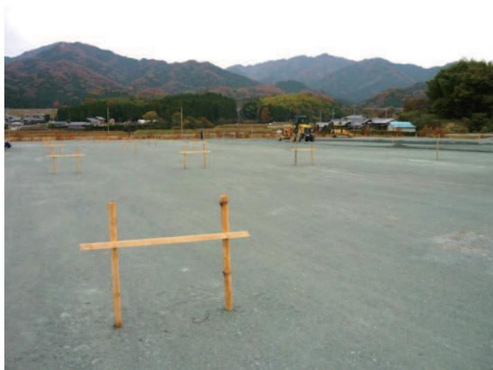
ブロックを設置するために、丁張を上げます。高さが高すぎる又は低すぎる場合には、バックホウにて調整してください。
