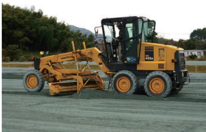
雑草などを伐採してから、モータグレーダで地盤を不陸整正し、振動ローラーにて転圧します。
