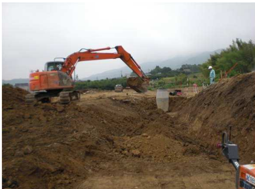
管の埋戻し状況
