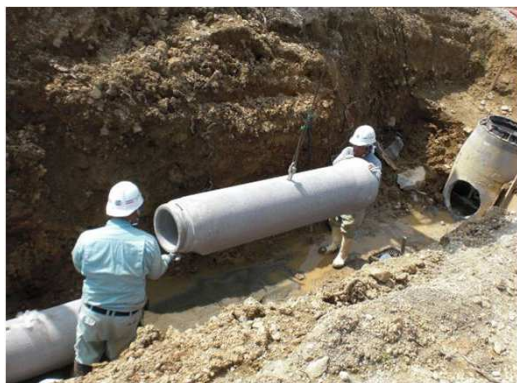
管の布設状況
