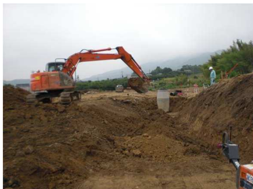
管の埋戻し状況
