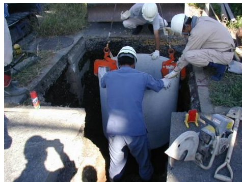
マンホール設置作業
