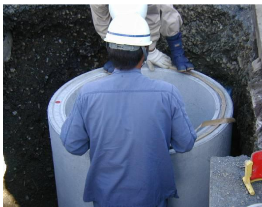
バイコンシールのセット状況
