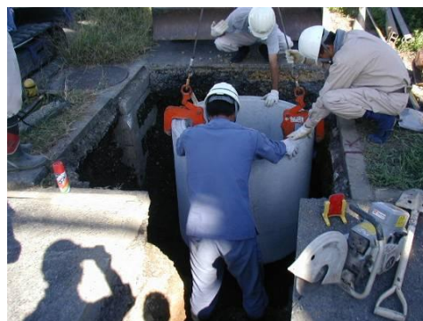
マンホール設置作業
