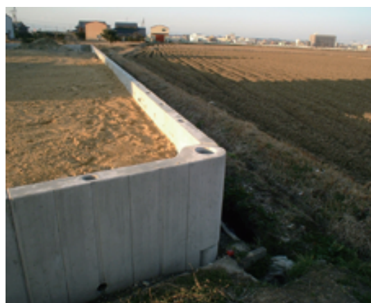
⑥設置完了
