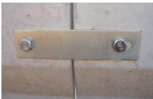
連結プレート取付状況
