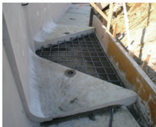
⑤底板現場打配筋状況
