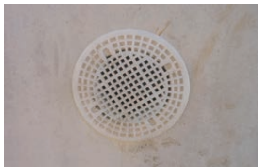
水抜孔用フィルター（背面側）
