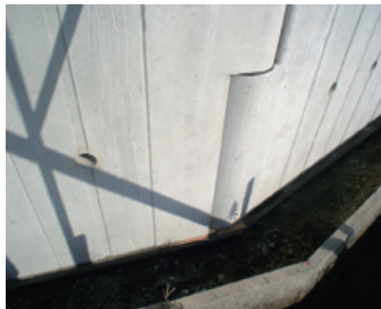
④接合部状況
